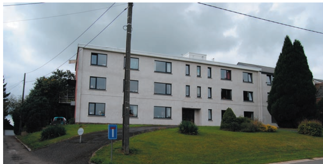
Façade à rue bâtiment existant
