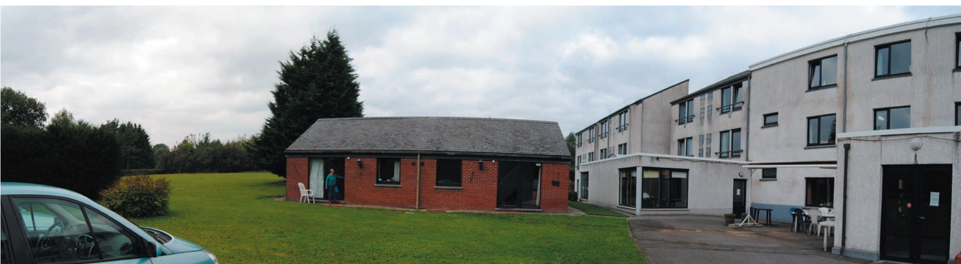
Bâtiment en zone arrière à démolir
