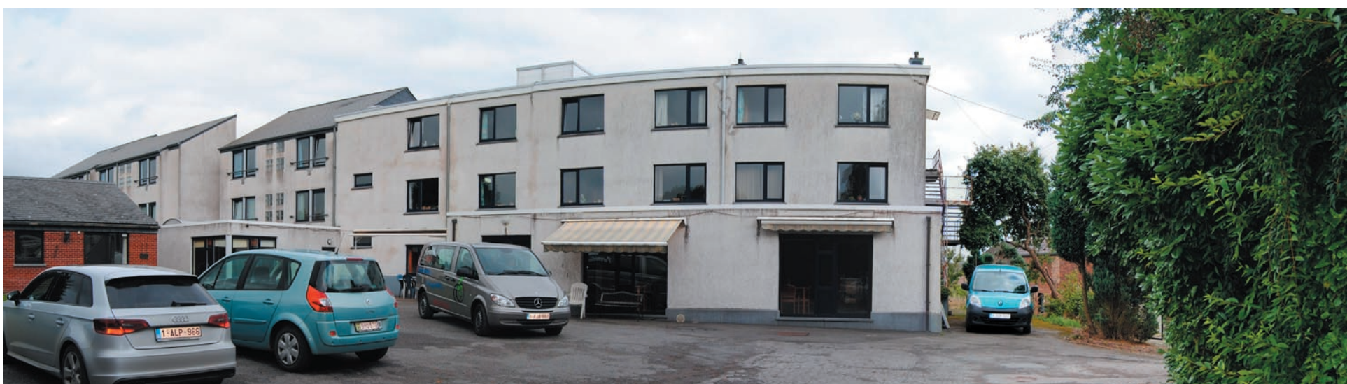
Façade arrière bâtiment existant - parking visiteurs
